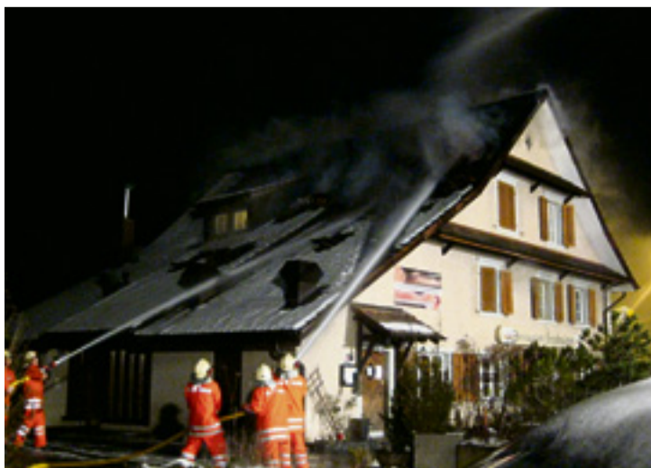
Im Dunkeln löscht die Feuerwehr den Dachstockbrand. Bild: Kapo ZH
